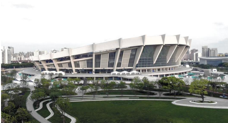
图 5.40 改造后体育场海绵城市设施（下凹绿地）
