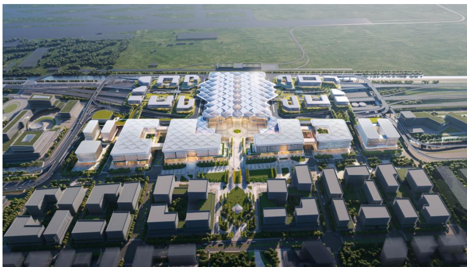
图 4.4 东方枢纽上海东站
