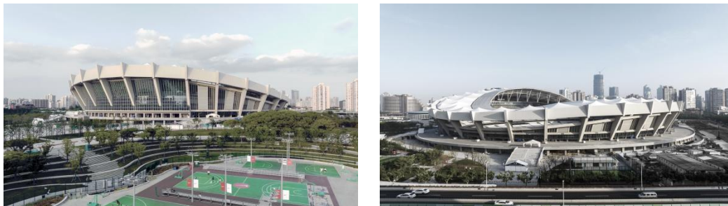
图 5.37 2021 年 FIFA 世俱杯上海体育场整体改造项目实景
