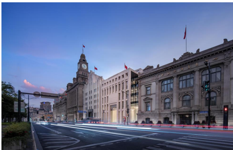
图 5.45 上海外滩国际大楼改造项目实景
