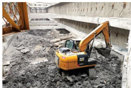
图5.13 远程控制基坑挖掘机器人
