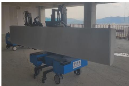
图 5.18 ALC板抓取运输机器人
