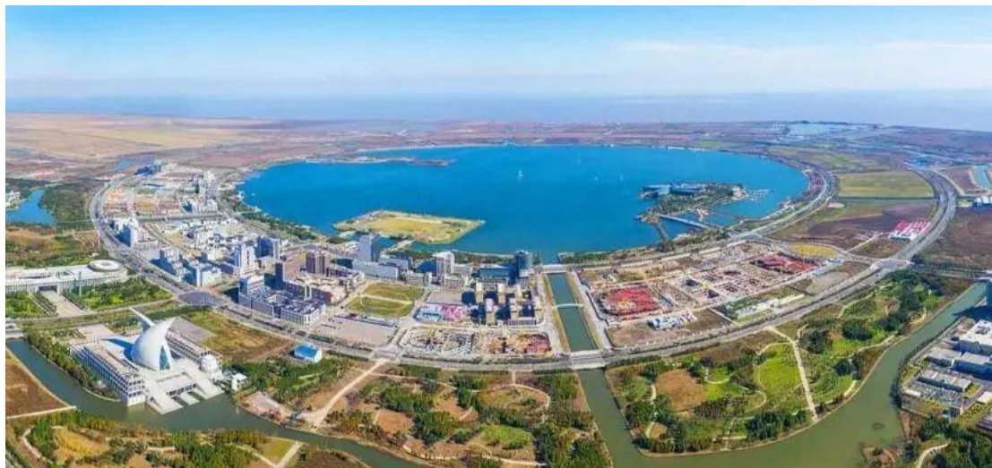
图4.12 临港新片区超低能耗集中示范区
