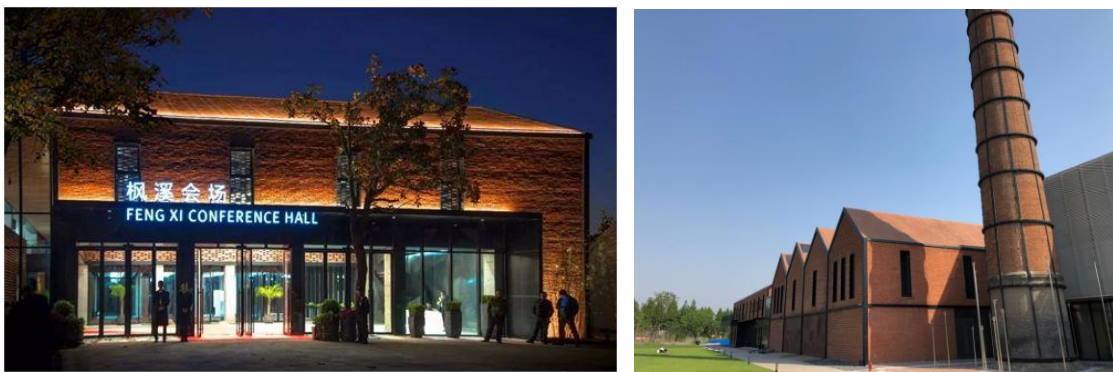
图 4.8 长三角路演中心 8 号楼枫溪会场项目图
