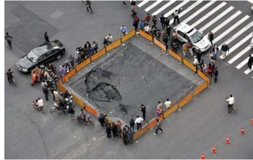
(d) 2011年10月27日上海火车站附近路面塌陷
